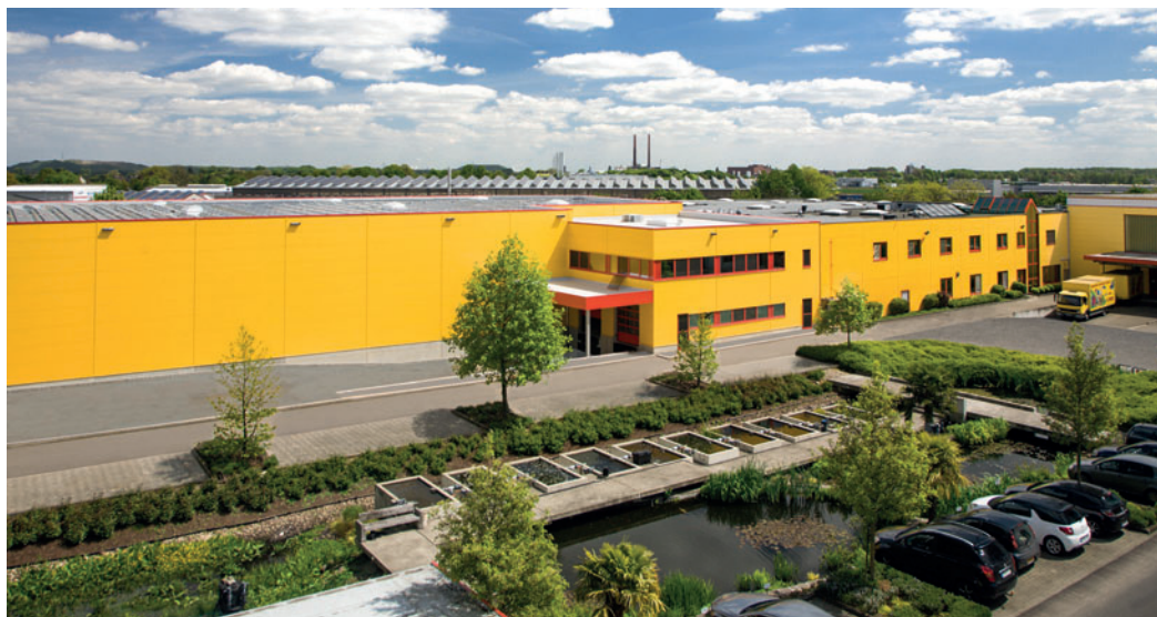
Le nouveau centre logistique de Sera héberge un département d'expédition optimisé.
